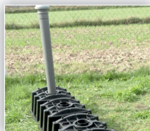
11. Na rurze rewizyjno-napowietrzającej należy zamontować kominek wentylacyjny. Zdjęcie przedstawia ułożenie nitki tuneli w linii prostej.
