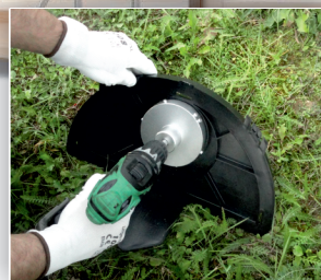
2. Przy użyciu otwornicy wyciąć fabrycznie zaślepiony otwór, którym będą doprowadzane ścieki.
