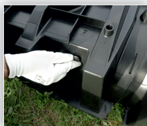
10. Po ułożeniu całej nitki tuneli należy zamontować zaślepki, które dołączone są do zestawu.
