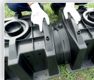
6. Podczas układania tuneli sprawdzić połączenie między nimi.
