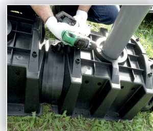
9. Podłączyć rurę rewizyjno-napowietrzającą, a następnie zabezpieczyć wkrętem INOX.
