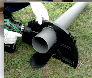
3. Rurę Ø 110 doprowadzającą ścieki wsunąć na ok. 6 cm do wyciętego wcześniej otworu oraz zabezpieczyć wkrętem INOX.
