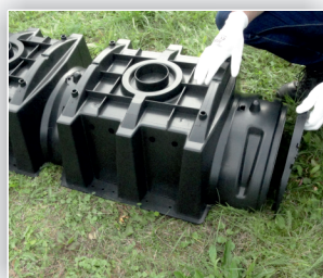
7. Ostatni tunel zakończyć deklelem.
